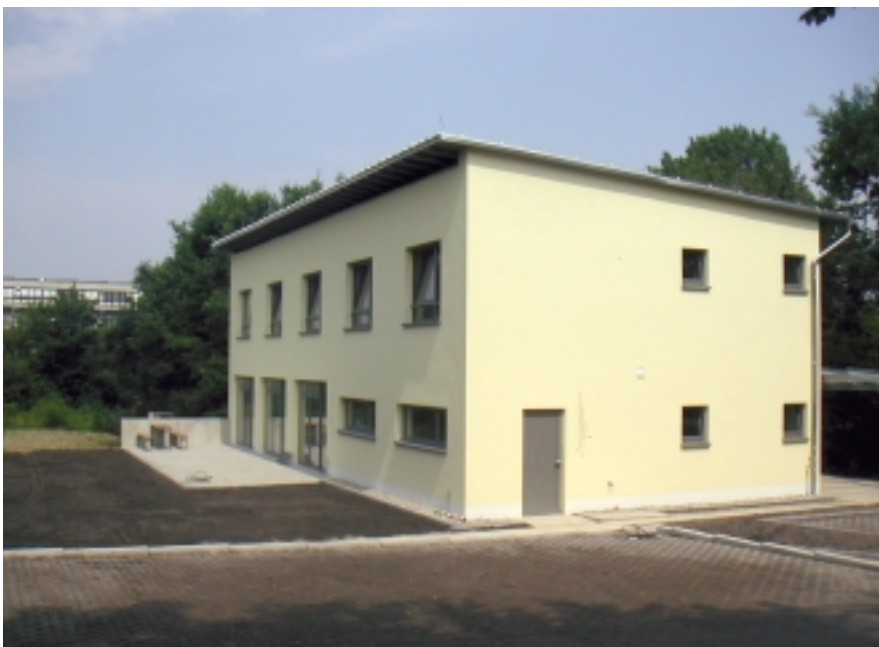
Das neue Verbindungshaus am Vogeliusweg.
